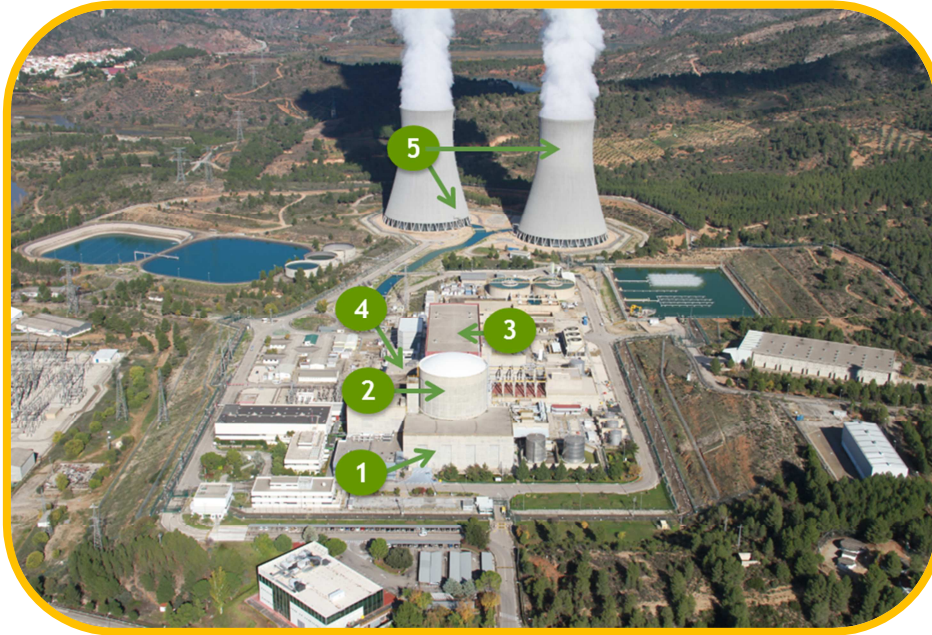
Figura 4. Edificios principales C.N. Cofrentes.
