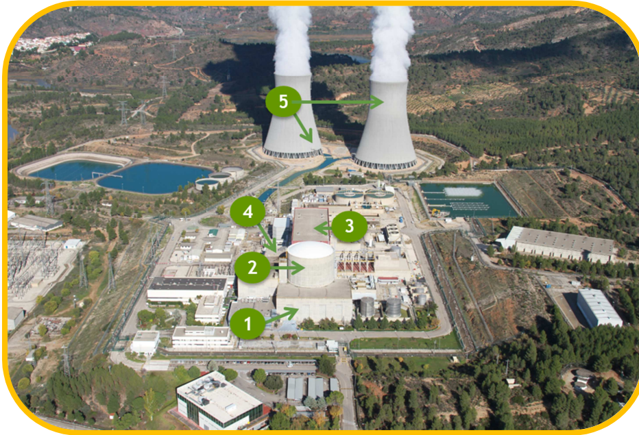
Figura 4. Edificios principales C.N. Cofrentes.
