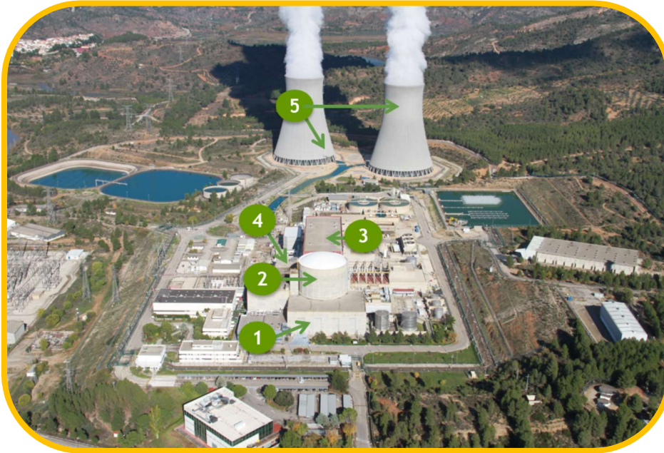
Figura 4. Edificios principales C.N. Cofrentes.
