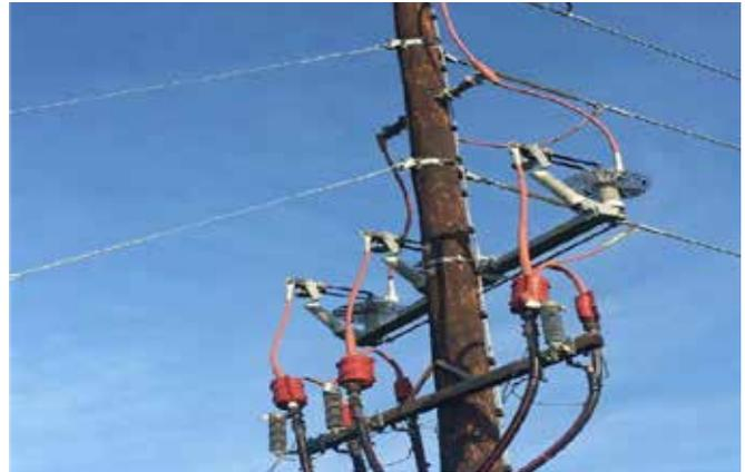
Ejemplo de un poste con cubiertas y barreras para minimizar el riesgo de electrocución de la fauna y la consiguiente interrupción del funcionamiento de la planta.
