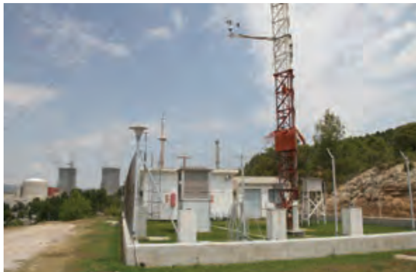
Estación meteorológica de Central Nuclear de Cofrentes
