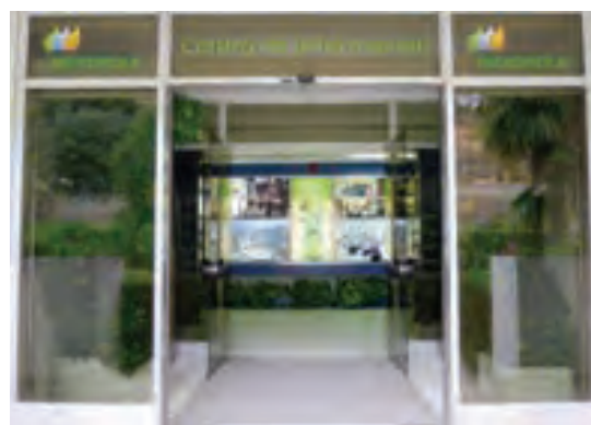
Centro de información de la Central Nuclear de Cofrentes
