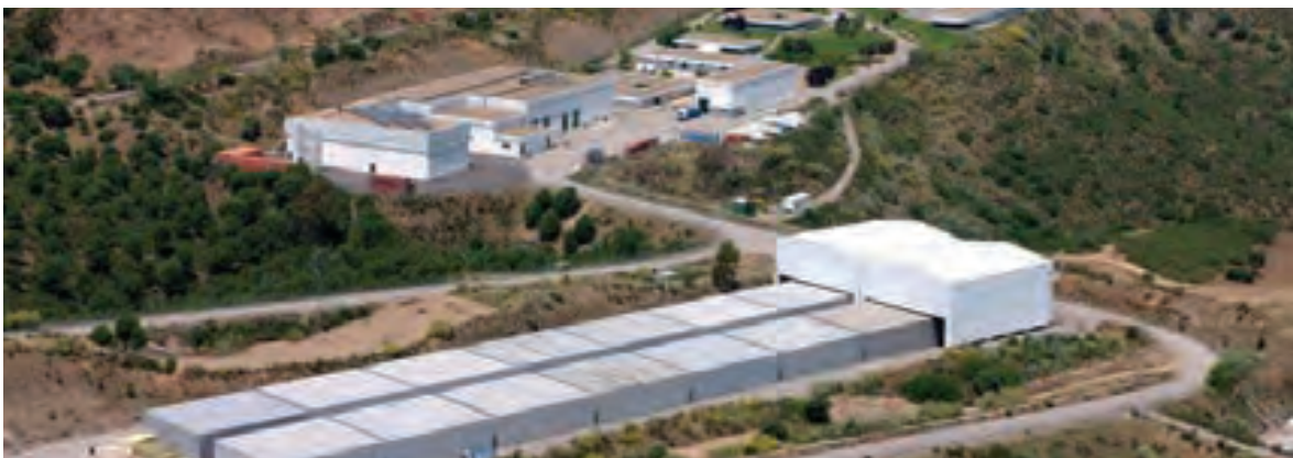
Centro de Almacenamiento de El Cabril
