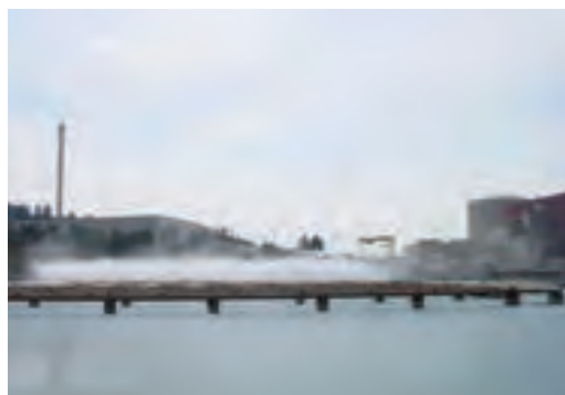
Estanque de agua de servicios esenciales
