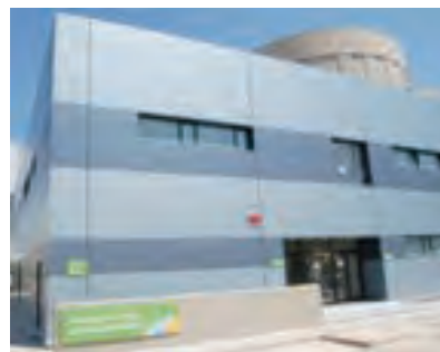
Nuevo acceso a zona controlada
