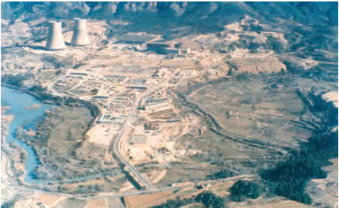
Central Nuclear de Cofrentes en construcción
