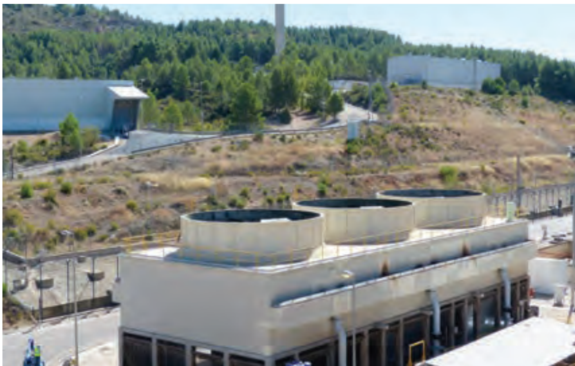
Torres tiro mecánico
