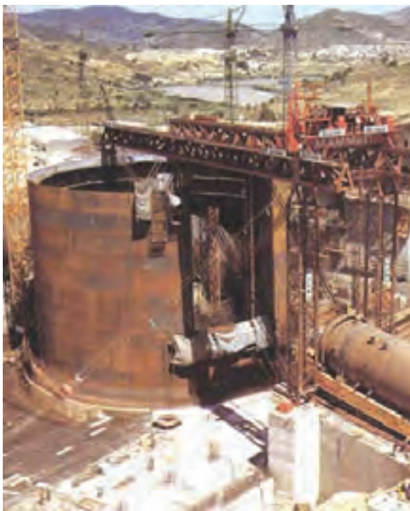
Transporte, izado y colocación de la vasija
