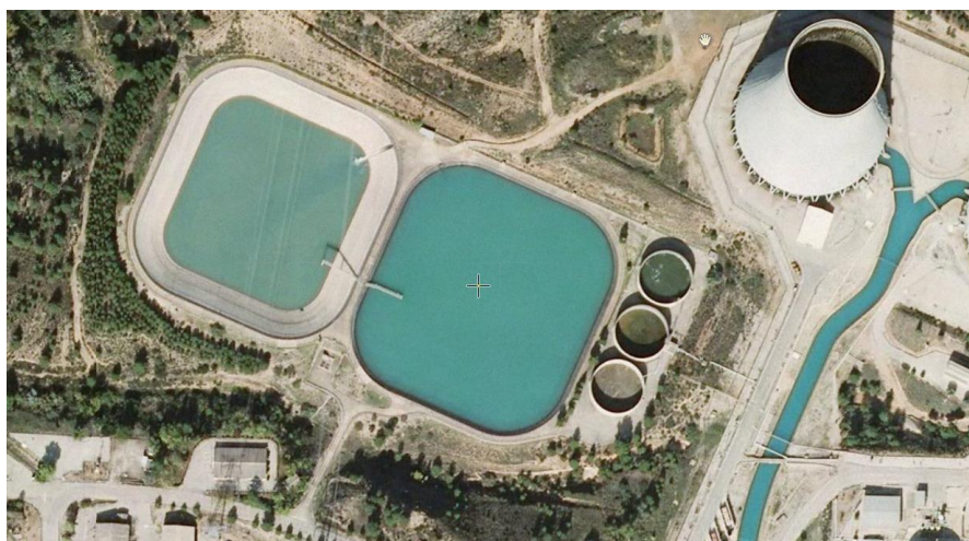
Fotografía 2. Vista aérea de los tres Tanques Intermedios de Hormigón y de las dos Balsas de Vertidos.
