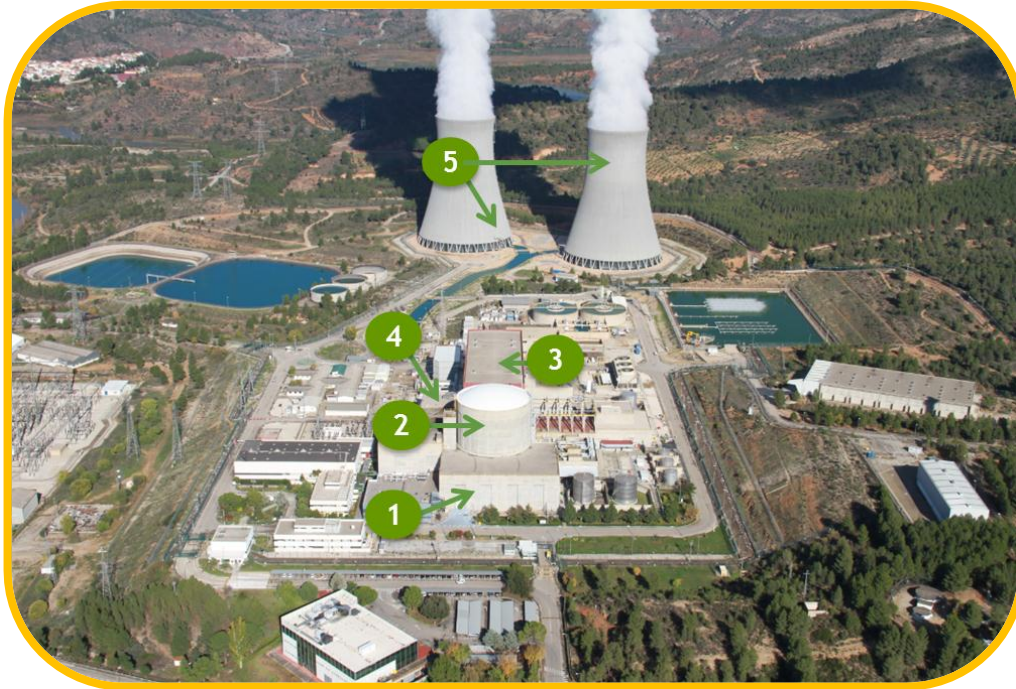
Figura 4. Edificios principales C.N. Cofrentes.
