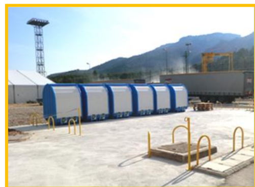
Imagen. Nuevo almacenamiento intermedio de residuos peligrosos en C.N.Cofrentes
