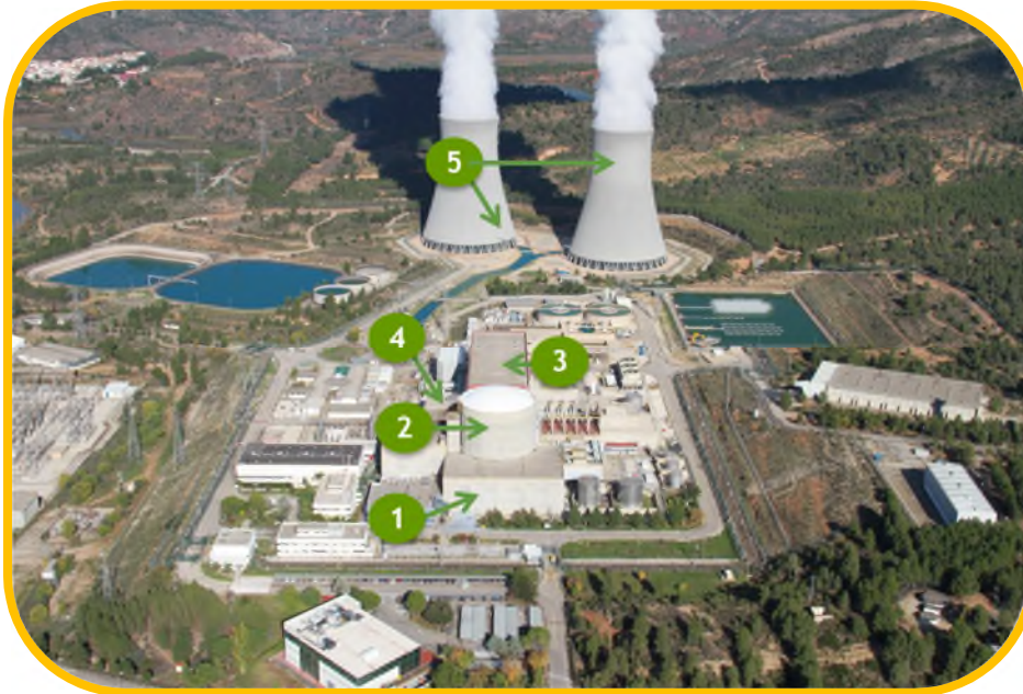
Figura 4. Edificios principales C.N. Cofrentes.
