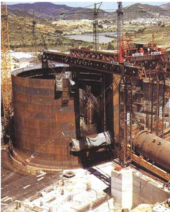
Transporte, izado y colocación de la vasija
