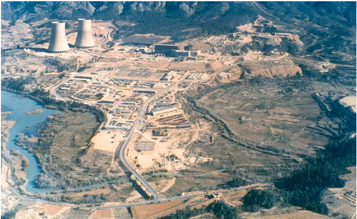
Central nuclear de Cofrentes en construcción
