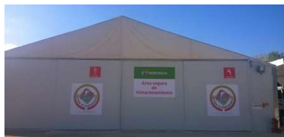
Área segura de almacenamiento
