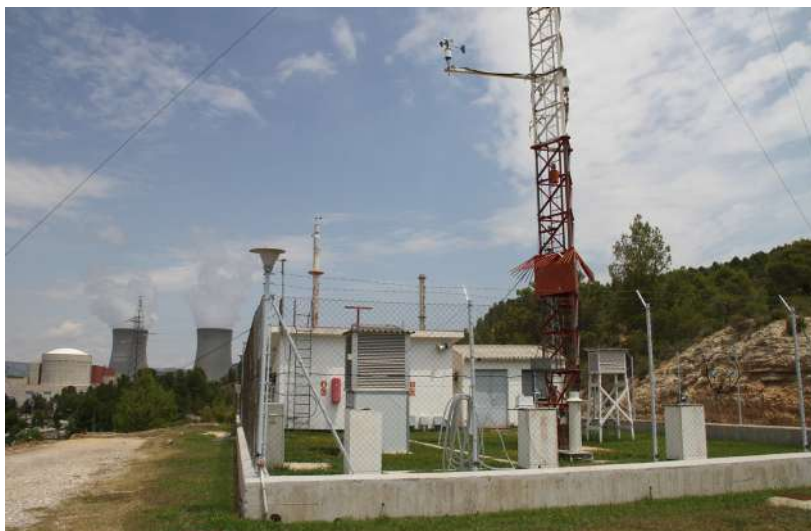
Estación meteorológica de central nuclear de Cofrentes
