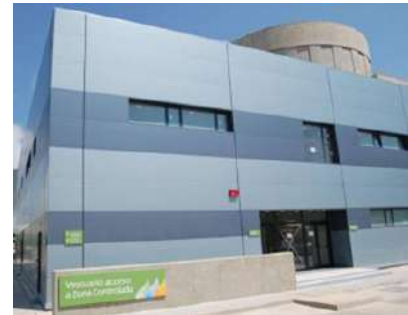
Acceso a zona controlada
