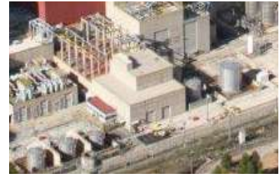
Edificio de tratamiento de desechos radiactivos
