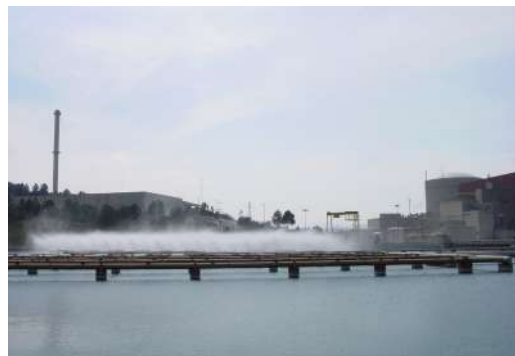
Estanque de agua de servicios esenciales
