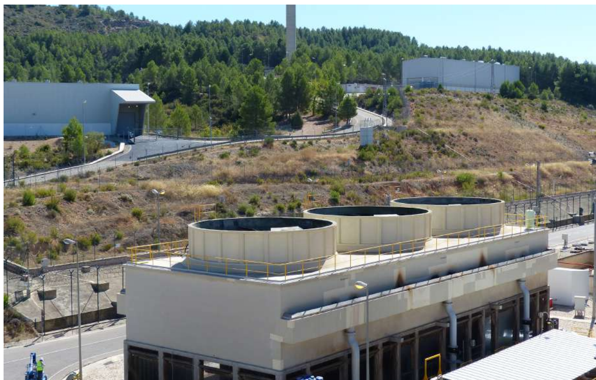
Torres tiro mecánico
