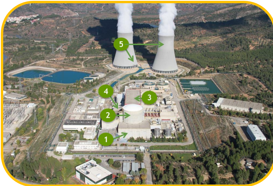
Figura 5. Edificios principales C.N. Cofrentes.
