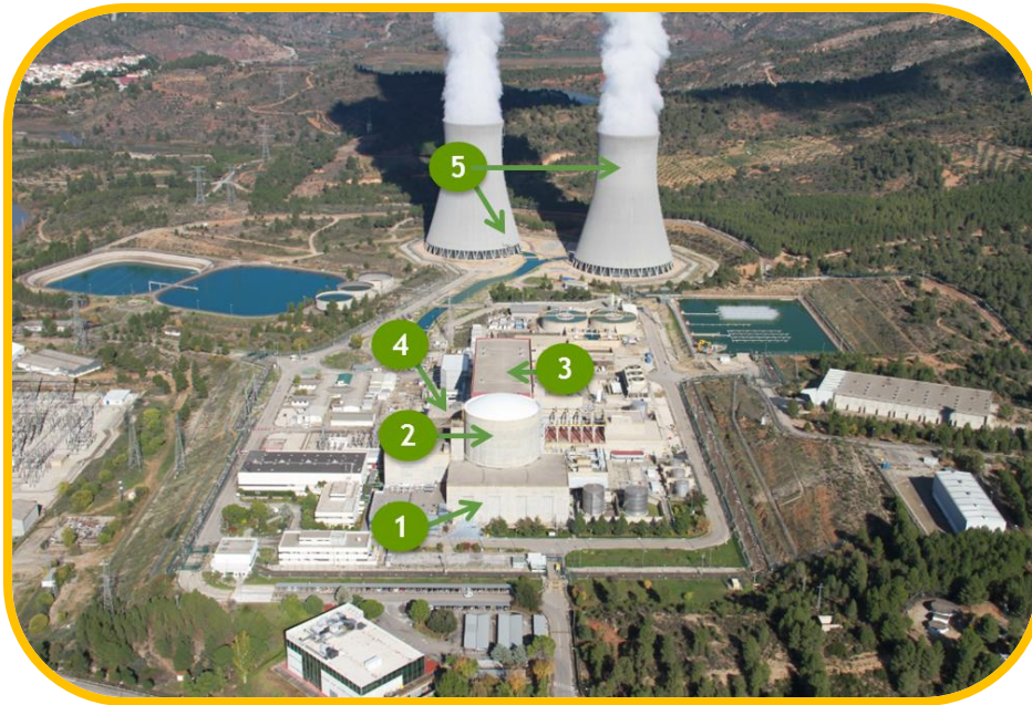
Figura 5. Edificios principales C.N. Cofrentes.
